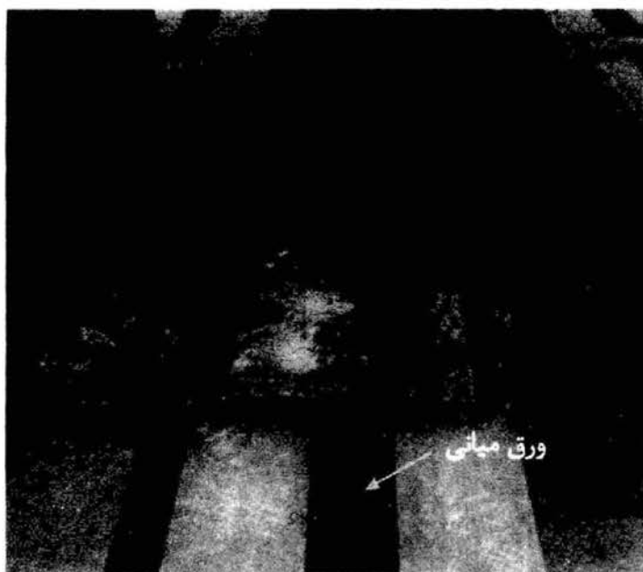
شکل ۹-۳۲ جزئیات ورق اتصالی در قاب‌های خمشی.
