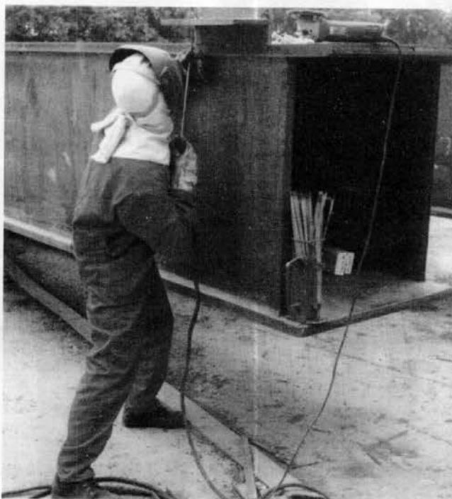
(ت) جوشکار حین جوشکاری سقفی
