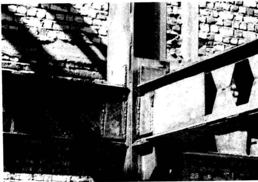
شکل ۷-۹ نمونه جوش‌های پذیرفته شده در بازرسی عینی.
