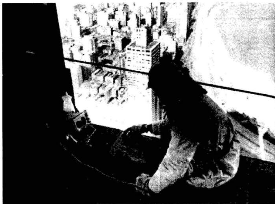
شکل ۸-۳۴ کاربرد یک دستگاه آزمایش فراصوتی قابل حمل در کنترل جوش ساختمانی در طبقه ۷۶ یک آسمان خراش.
