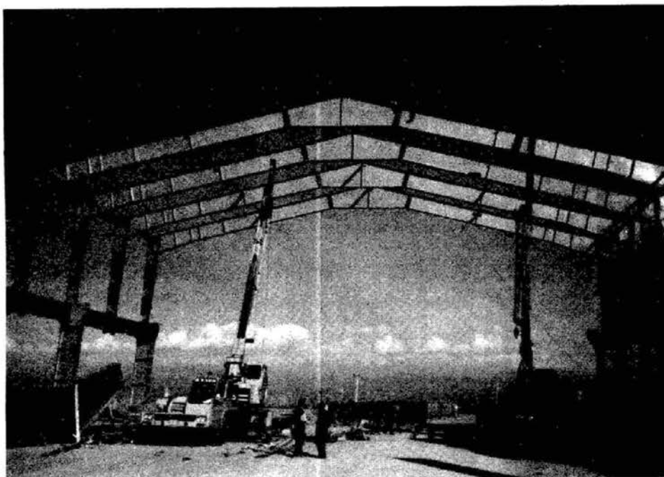
شکل ۹-۶۲ نصب قاب‌های ساختمان‌های صنعتی.
