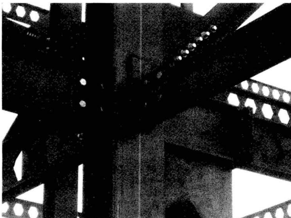
شکل ۱۴-۱۴ اجرای مناسب اسکلت فولادی.
