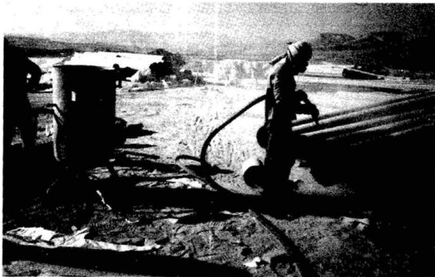
شکل ۹ - ۵۵ عملیات ماسه‌پاشی.
