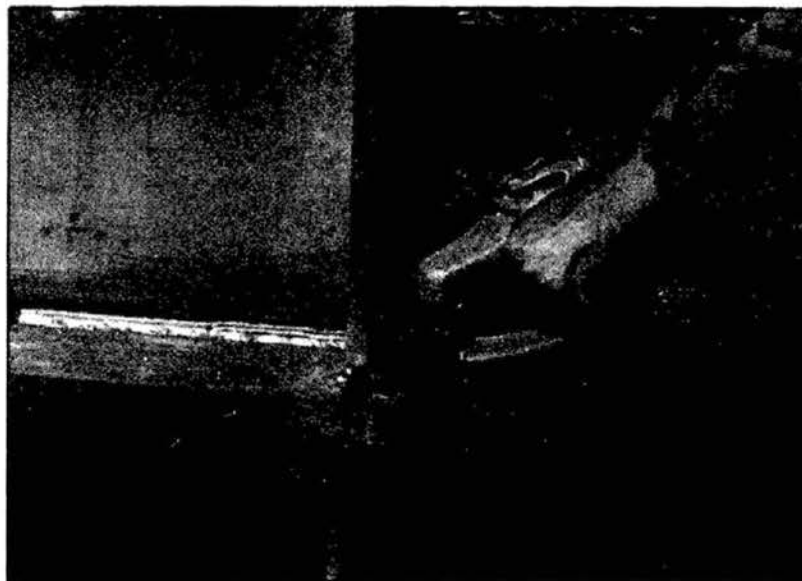
(پ) سنگ‌زنی درز جوش‌های شیاری پس از اجرای جوش گوشه پشت آنها
