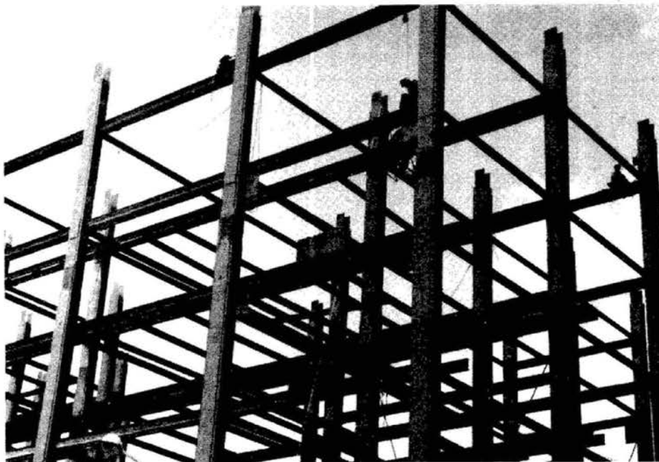
شکل ۹-۶۵ شاقولی کردن ستون‌ها و هم‌محور کردن تیرها.
