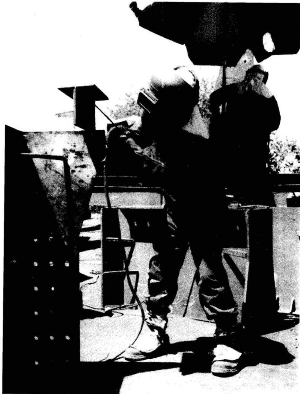
شکل ۸-۹ انجام جوش گوشه آزمایشی در وضعیت سقفی (۴۴).
