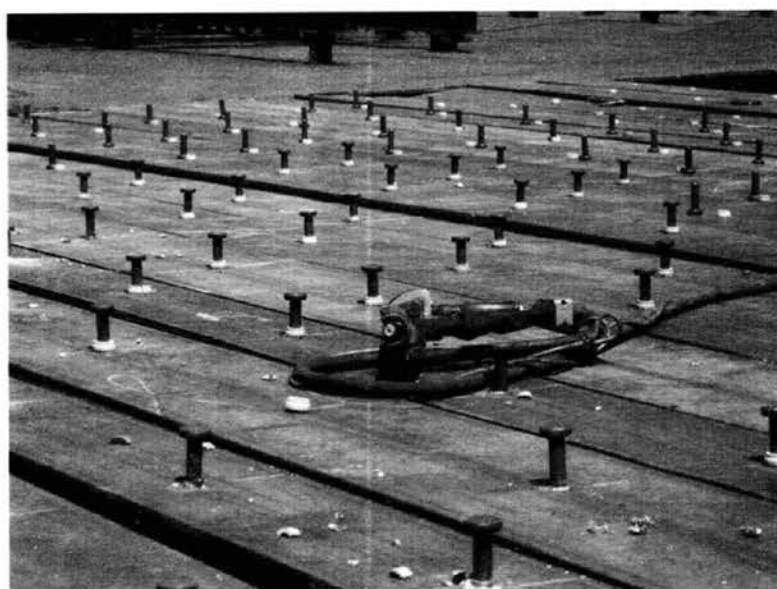
شکل ۱- ۱۶ جوشکاری گل میخ به روش قوسی با انبر تپانچه‌ای شکل در کارگاه.
