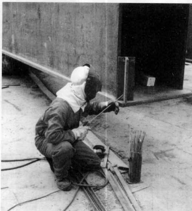
(ب) جوشکار حین جوشکاری سربالا
