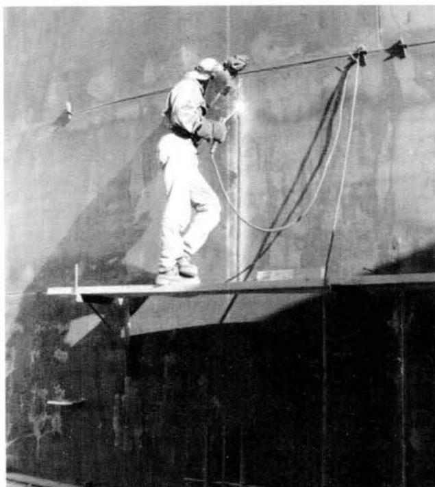
(ب) جوشکاری دستی در حالت سر بالا
