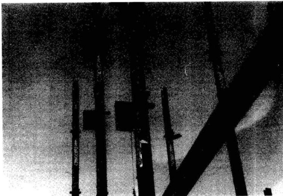
شکل ۹-۶۱ نصب و واداشتن ستون‌ها.
