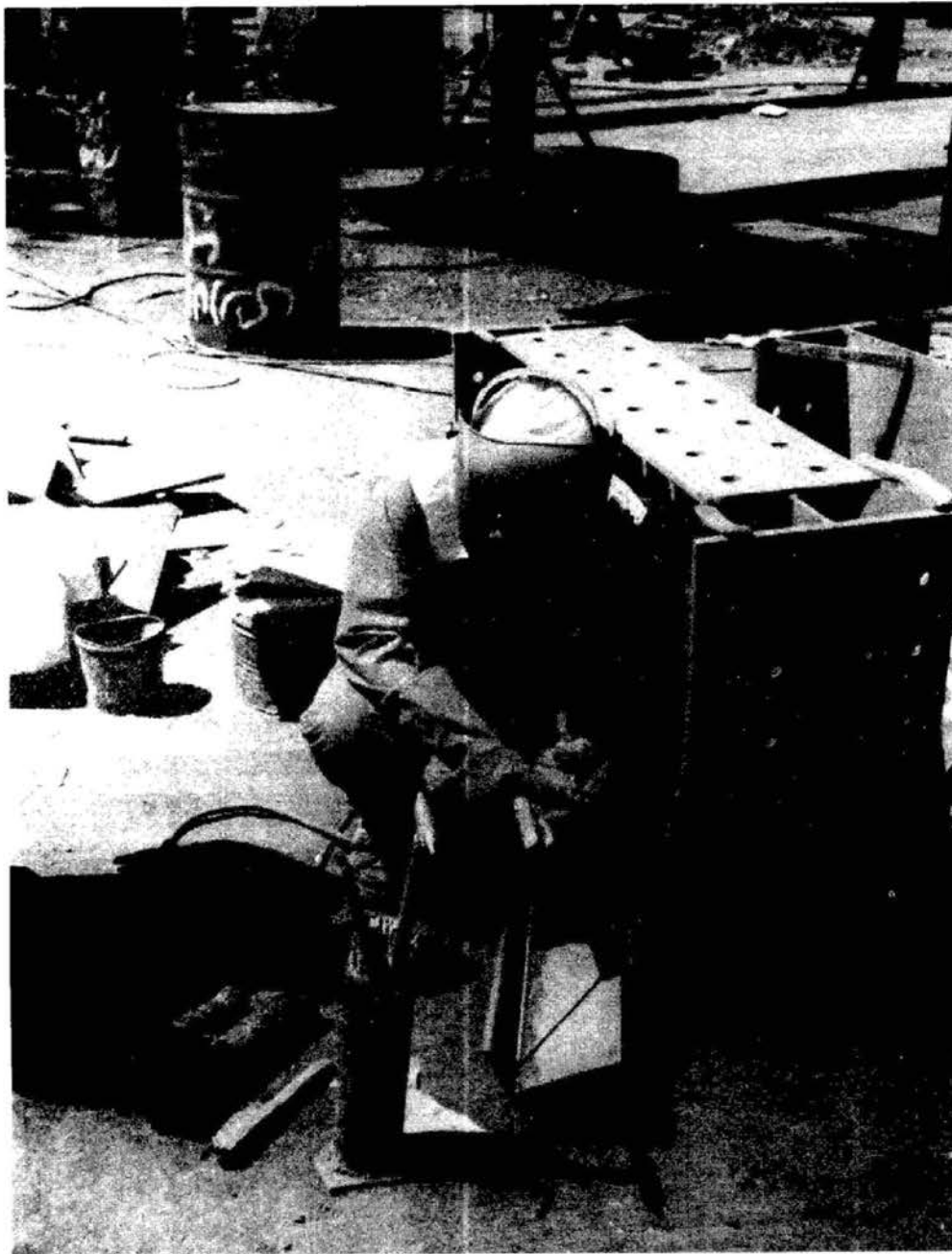
شکل ۸-۶. انجام جوش گوشه آزمایشی در وضعیت تخت (A).
