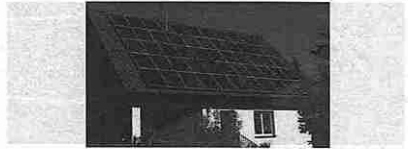
شکل ۸۷ ترکیب مدول‌های فتوولتائیک با بام شیبدار
