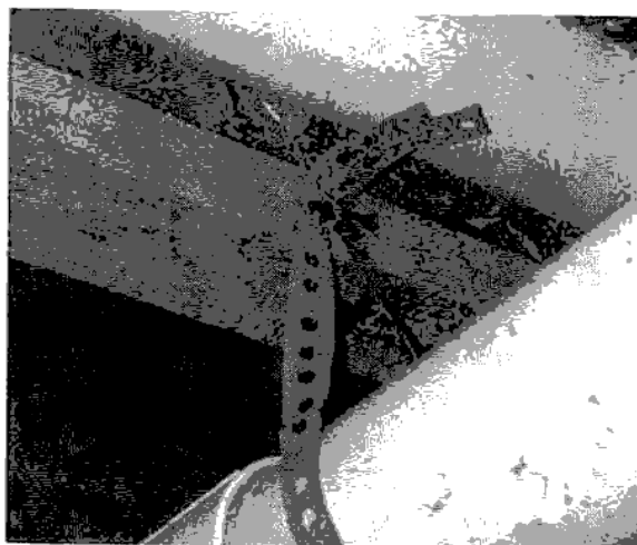
شکل (۲-۹-۱۶) بست آویز نامناسب از تسمه فلزی با اتصال ضعیف به تیر چوبی
