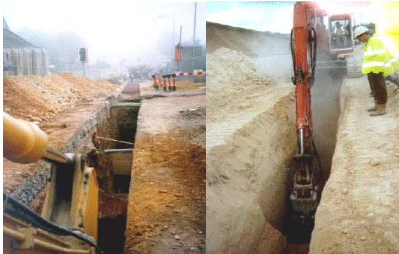
شکل ۳-۵-۳- کاربرد باکت حفار در حفر ترانشه
