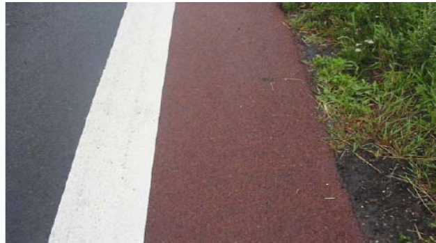
شکل شماره ۲-۲۰-۲- بازسازی شانه ها
