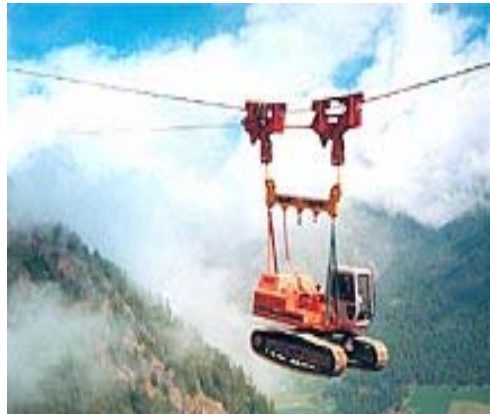
شکل ۶-۶-۱- جرثقیل کابلی در حال حمل بیل مکانیکی
