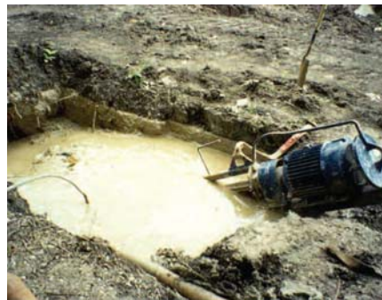
شکل ۳-۲۹-۵- گل حفاری در حال خروج از چال
