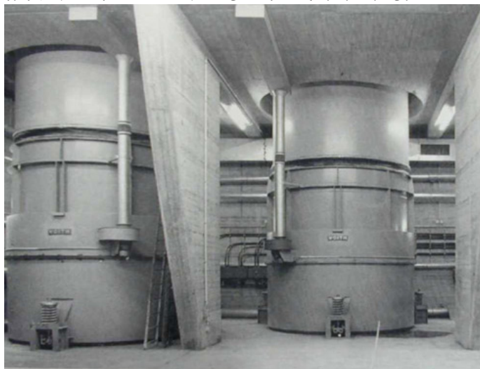
شکل ۶-۱۴-۹- بادبزن محوری قائم در تونل Elbe آلمان
