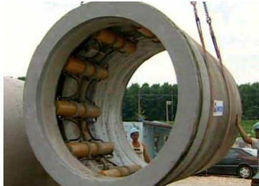
شکل ۵-۱۰-۴- لوله بتنی مخصوص عملیات لوله رانی
