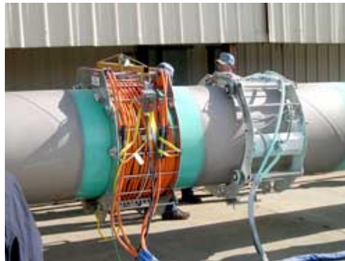
شکل ۵-۴-۸- سیستم پوشش دهی محل اتصال
