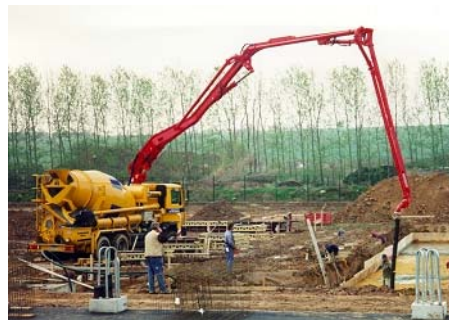
شکل ۴-۹-۸- پمپ بتن سوار شده روی تراک میکسر
