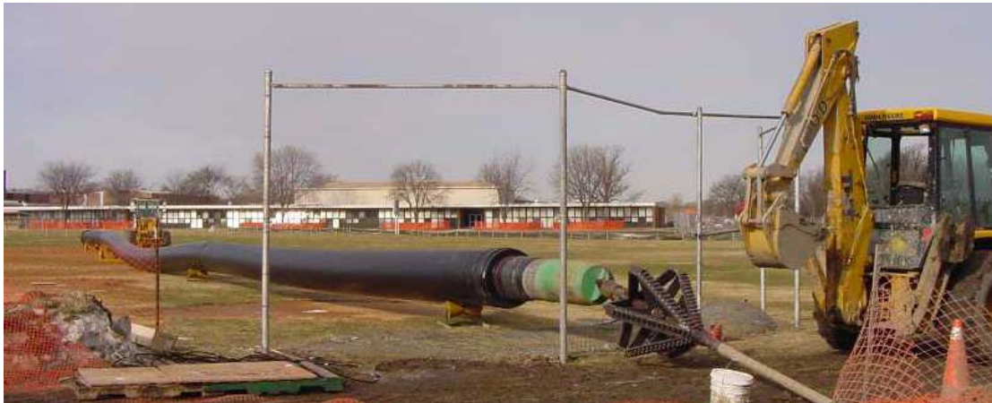
شکل ۳-۲۹-۸- لوله متصل به راد و آماده کشش
