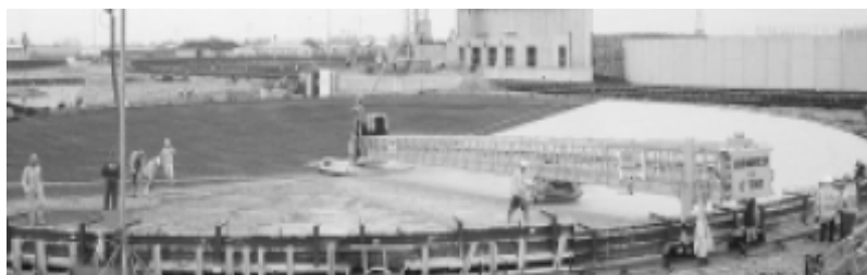
شکل ۴-۱۶-۵- استفاده از فینیشرسیلندری برای اجرای سطح دایروی
