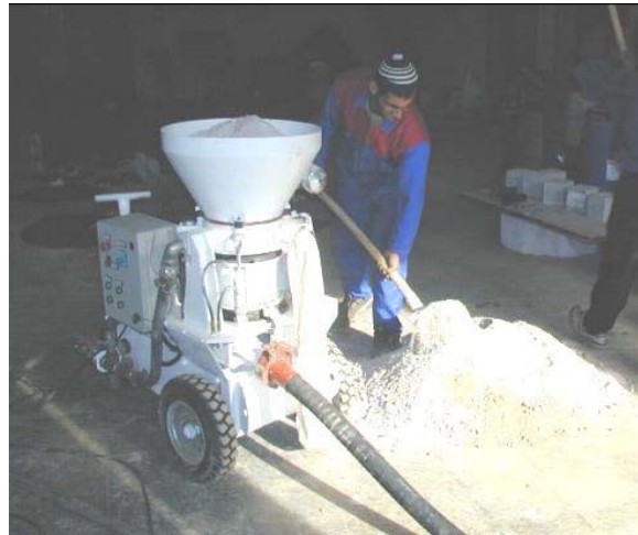
شکل ۴-۱۸-۴- نحوه ریختن مصالح در دستگاه پمپ شاتکریت
