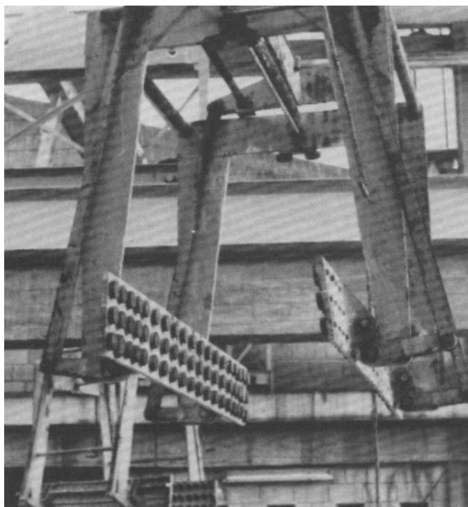
شکل ۴-۱۵-۱۱- دستگاهی برای بلند کردن دالها با قطعات لاستیکی رویه
