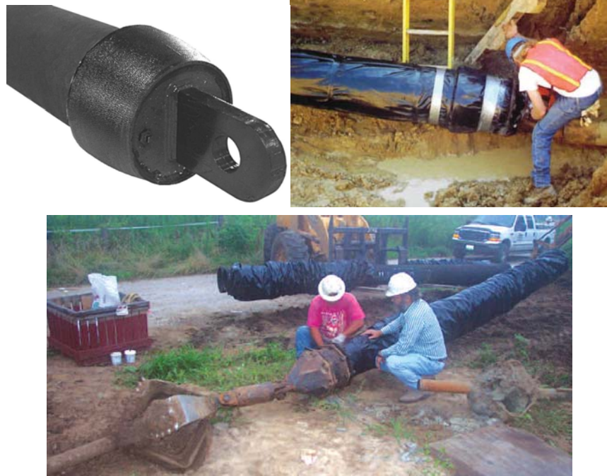
شکل ۳-۲۹-۷- نصب لوله به راد
