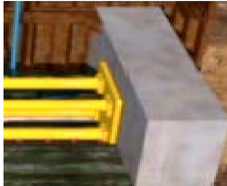
شکل ۵-۱۰-۷- دیوار فشاری پشت دستگاه (THRUST WALL)
