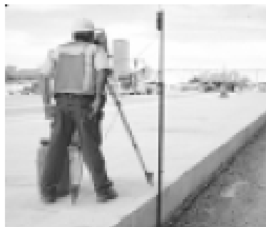
شکل ۴-۱۶-۱۱- کنترل مسیر بوسیله ریسمان و یا به صورت الکترونیکی (دو روش مختلف)
