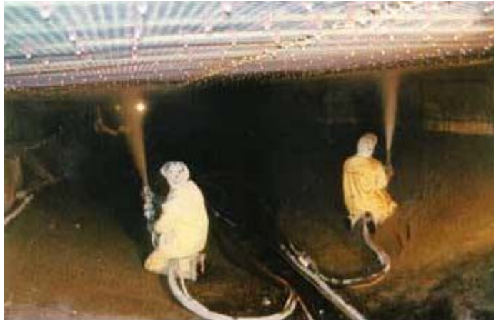
شکل ۴-۱۸-۱- نمایشی از کاربرد شاتکریت
