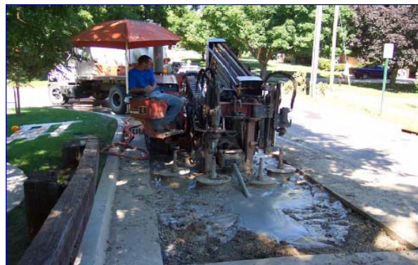
شکل ۳-۲۹-۱- نمایش ماشین H.D.D در حال حفاری در یک منطقه شهری
