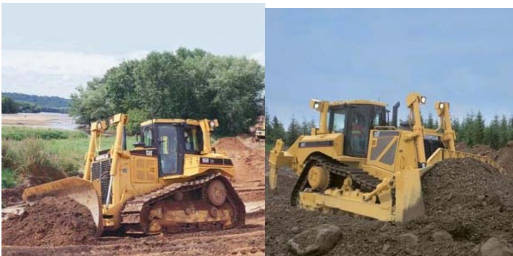
شکل شماره ۲-۲-۱- بولدوزر در حین عملیات خاکی
