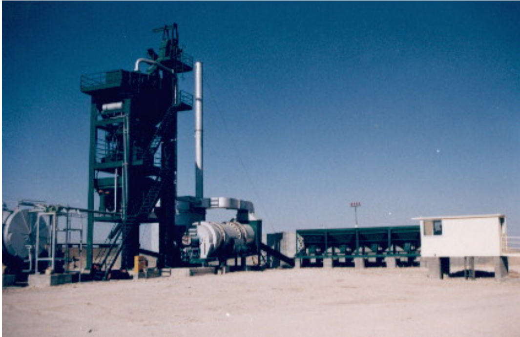
شکل شماره ۲-۲۱-۱- کارخانه آسفالت
