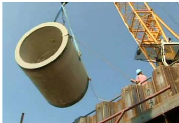
شکل ۵-۱۰-۳- هدایت لوله‌های بتنی درون شفت ارسال
