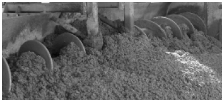
شکل ۴-۱۶-۸- پخش کردن بتن توسط تیغه ماریچ
