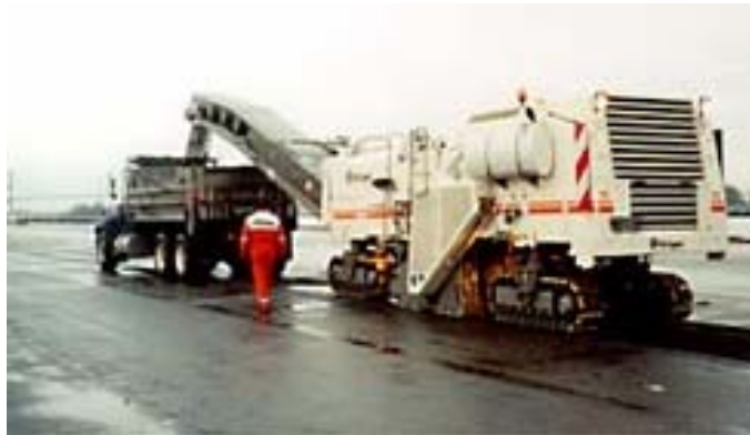
شکل شماره ۲-۱۳-۶- نقاله انتقال دارای پوشش
