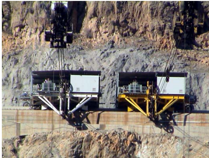
شکل شماره ۶-۶-۴- نمایی نزدیک از واگن‌های اصلی سیار جرثقیل کابلی موازی کارون ۳ (جناح راست)
