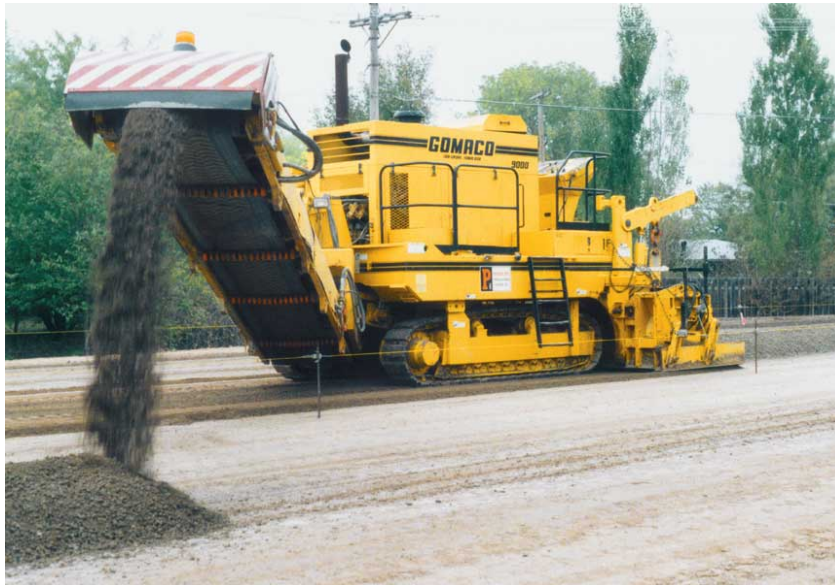
شکل شماره ۲-۱۸-۳- تسمه نقاله تریمر آسفالتی
