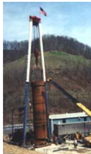
شکل ۳-۱۴-۵. نمایی از کیسینگ فولادی و قرار دادن آن در چاه
