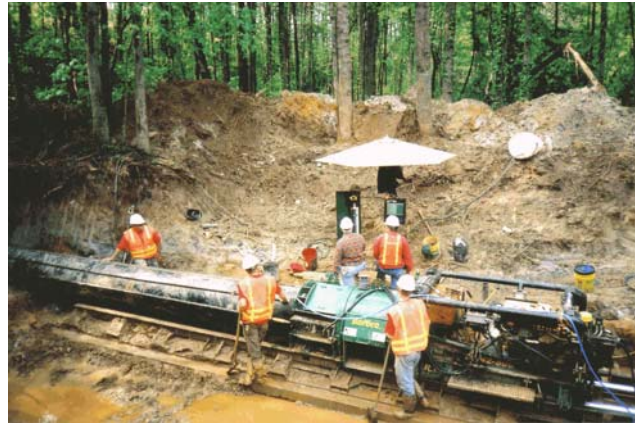
شکل ۳-۴-۷- استفاده از اوگر برای حفاری افقی
