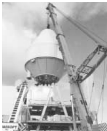
شکل شماره ۴-۳-۵- دیگ بچینگ در حال نصب
