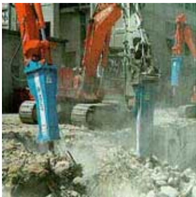
شکل ۳-۱۰-۳- تخریب ساختمانهای قدیمی
