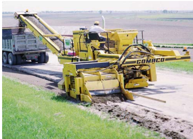
شکل شماره ۲-۱۸-۱- ایجاد شانه راه توسط تریمر آسفالتی
