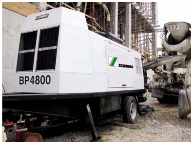
شکل ۴-۱۰-۴- پمپ بتن کارگاهی (زمینی)
