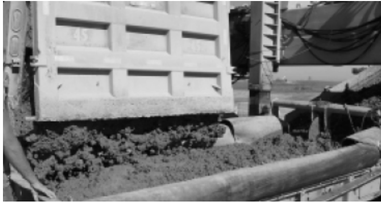
شکل ۴-۱۶-۷- تخلیه بتن در مخزن تسمه نقاله
