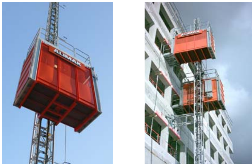
شکل ۶-۱۰-۴- بالابرهای تک و دو قفسی متداول
