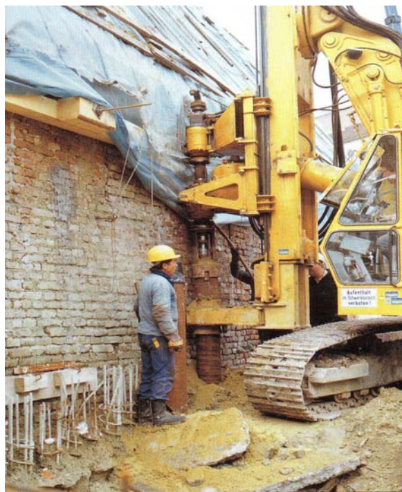
شکل ۳-۴-۱۰- حفاری با اوگر در مجاورت دیوار
