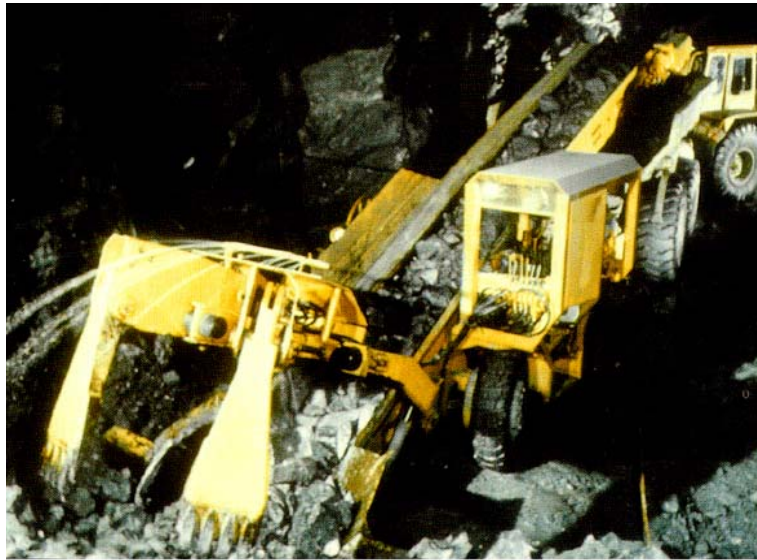
شکل ۳-۲۵-۷- حمل مواد به خارج از تونل بوسیله کامیون
