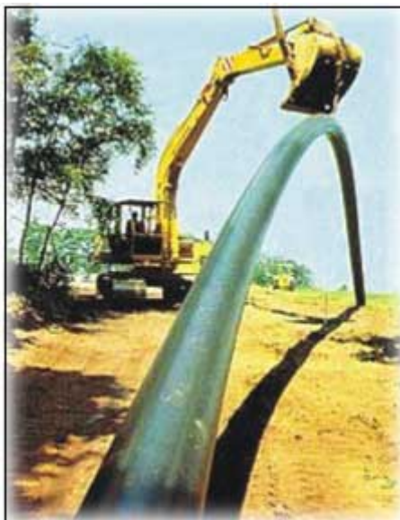
شکل ۵-۹-۲- نمونه کاربرد لوله پلی اتیلن در آبرسانی
