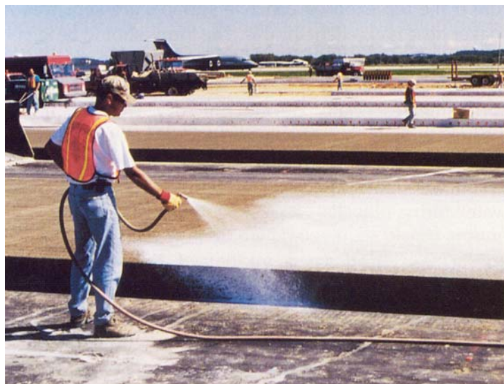
شکل ۴ روش عمل‌آوری با ماده شیمیایی غشایی
