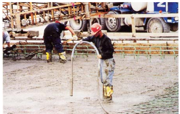
شکل ۴ همپوشانی، شعاع عمل و بیراتور و انجام شدن و بیره به صورت عمودی (تعیین فواصل نفوذ و بیراتور)
