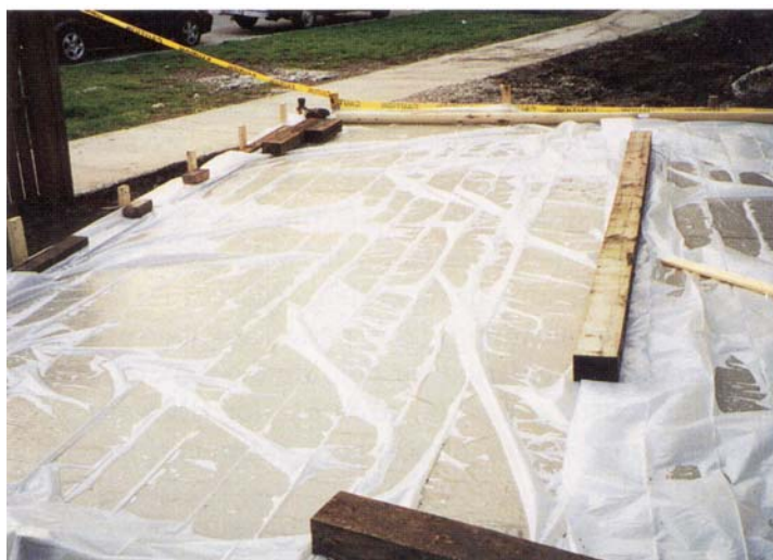
شکل ۲ عمل آوری با پلاستیک
