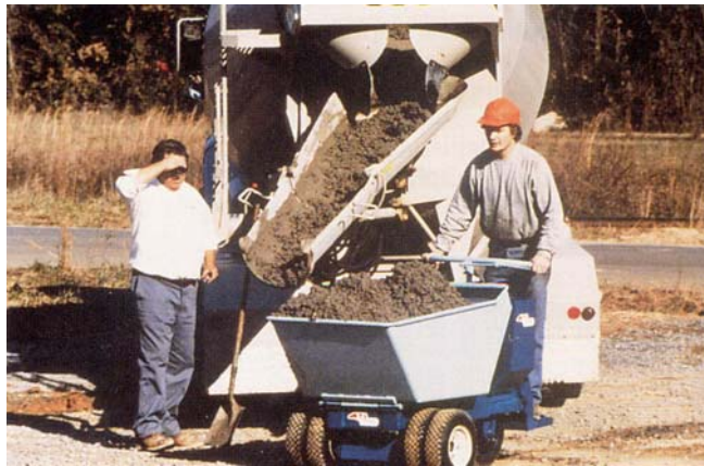
شکل ۲ انتقال بتن با استفاده از فرغون موتوری
