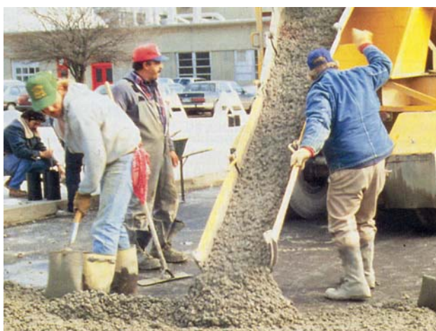
شکل ۴ انتقال بتن با استفاده از سطح شیب‌دار
