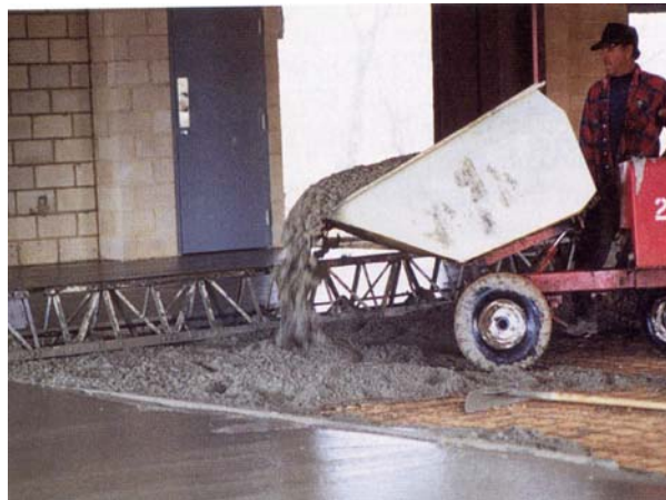
شکل ۳ روش صحیح ریختن بتن
