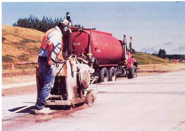
شکل ۱ استفاده از دستگاه برش برای ایجاد درز
