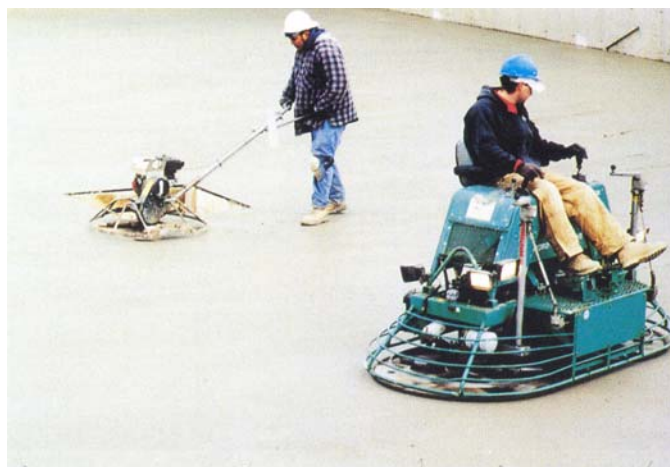
شکل ۶ پرداخت نهایی با ابزار مکانیکی
